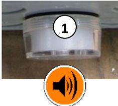
Abb. 10: Akustikmelder am Steuerschrank
